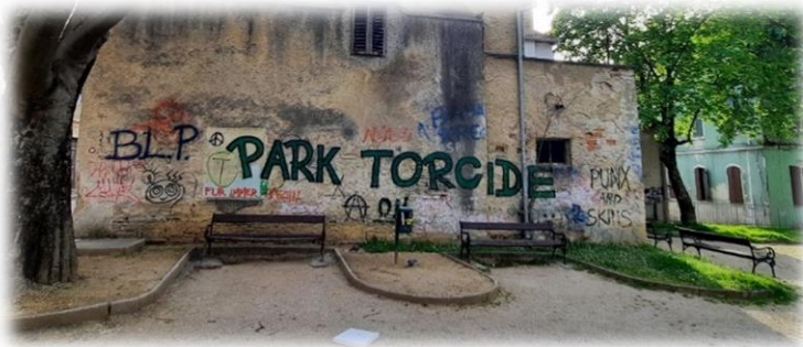
Slika 61 / Grafiti na pročelju zgrade koja se nalazi na prostoru zadanog obuhvata rada / autorica: Antonina Škrinjar
