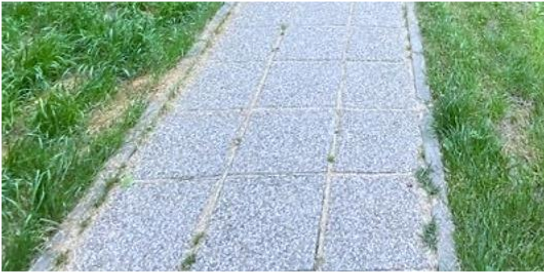
(slika 3.4.5.5 staza popločana betonskim pločama, Ivan Stošić, 2023.)
