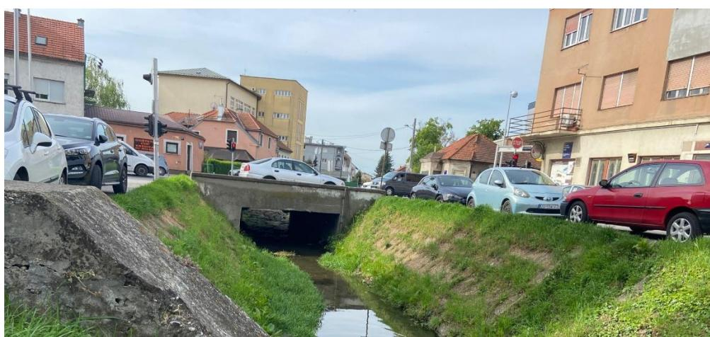
(slika 3.4.3.3 prolaz potoka ispod Ilice kroz kanal, profil kanala zemljjanog korita i stranicama koje nadsvođenjem prelaze u betonski tip kanala Ivan Stošić, 2023.)
