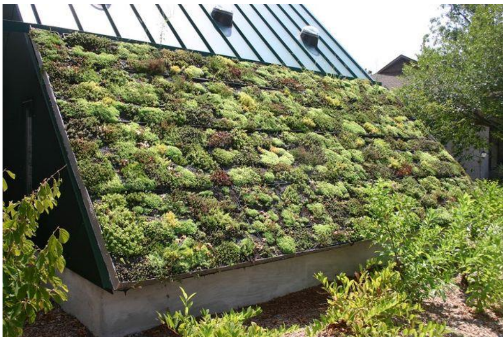
Slika 6. Prikaz primjene ekstenzivno-kosog vrta Izvor: https://odu-green-roof.com/light-extensive-green-roof/
