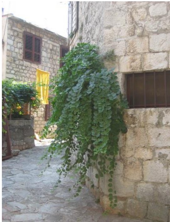
Slika 2.4.2. Kapar na zidu
