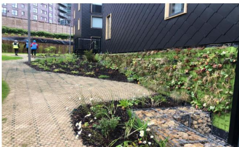
Slika 4.4.4. Prikaz propusnog opločenja, vertikalnog vrta, te biljaka za pročišćavanje vode. Climate Innovation District. Izvor: 009_01_06_20_climate_innovation_leeds_2020_awards.pdf - pristup 27.6.2022.
