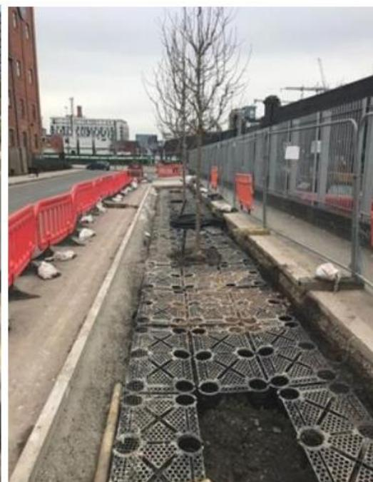
Slika 4.7.2. Princip održive odvodnje.
