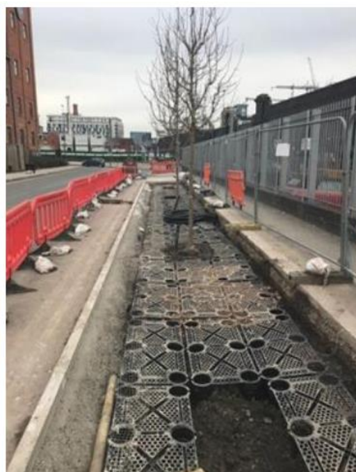
Slika 4.7.2. Princip održive odvodnje.
