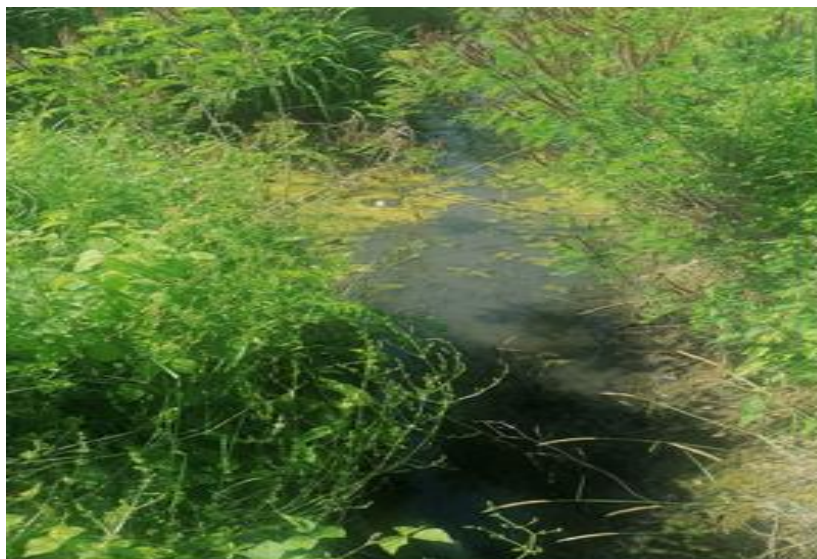
Slika 3.2.1. Melioracijski kanal Ljubljanica
