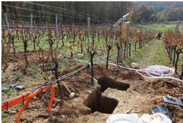
Slika 3.2.1. Iskop jame za postavljanje tlačnih lizimetara
