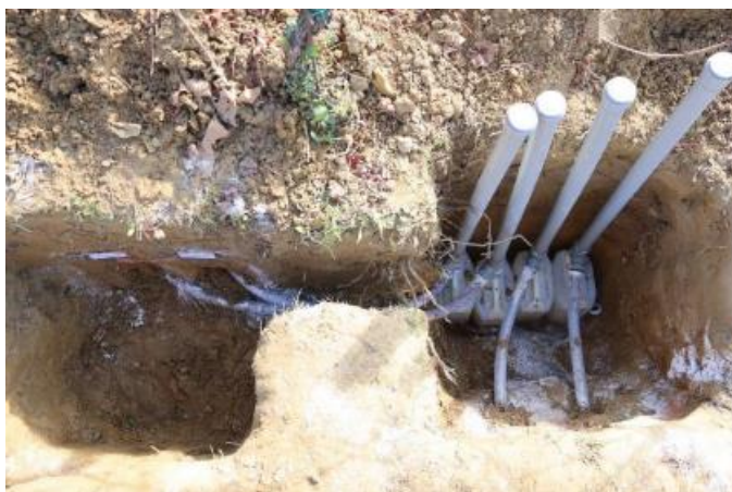
Slika 3.2.5. Spajanje armiranih fleksibilnih i vertikalnih cijevi na spremnik
