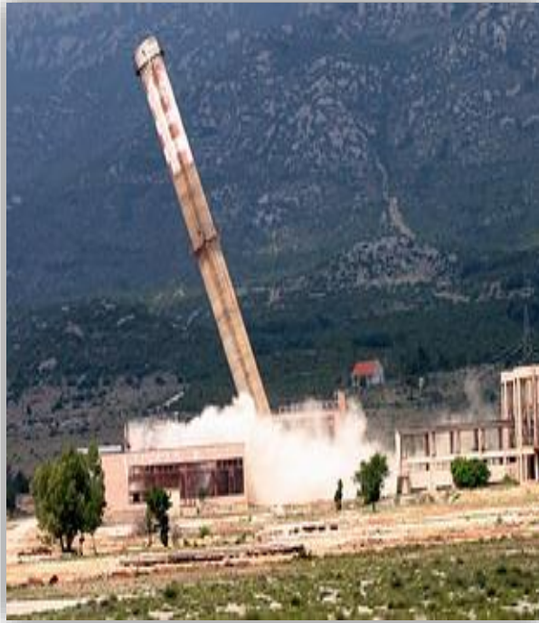
Slika 3. Rušenje dimnjaka posljednjeg simbola tvornice Jadral
