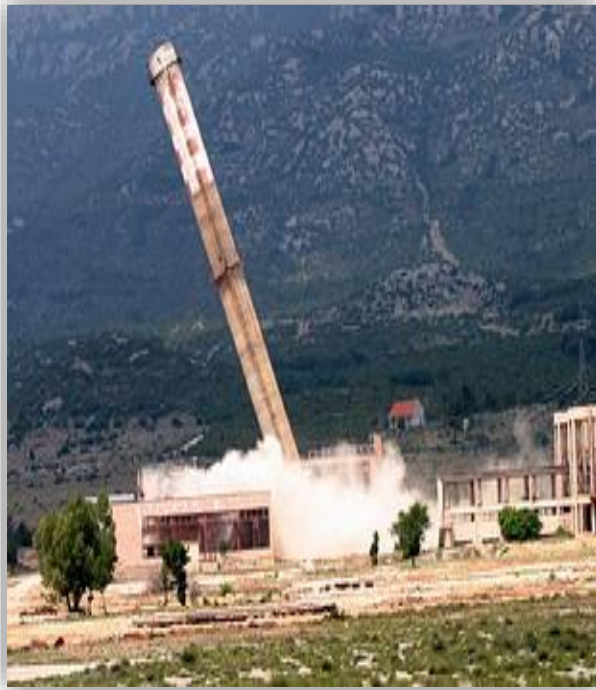
Slika 3. Rušenje dimnjaka posljednjeg simbola tvornice Jadral
