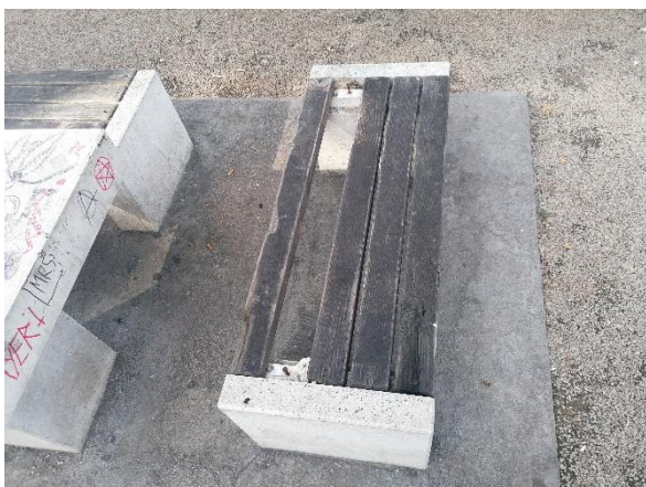
Slika 3.2.1.7. Park Luja Šoletića – oštećena klupa i pošaran stol
