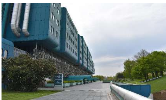
Slika 8.6.4. Pješački plato sa zapadne strane zgrade
