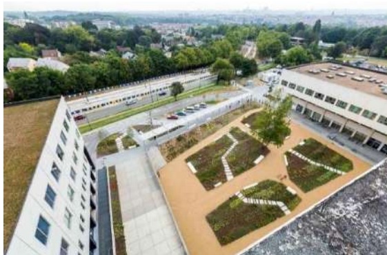
Slika 4.1.2. Vrt Sveučilišne bolnice Jette Izvor: http://landezine.com/index.php/2017/02/university-hospital-brussels-by-omgeving/ (pristup 10. travnja 2021.)
