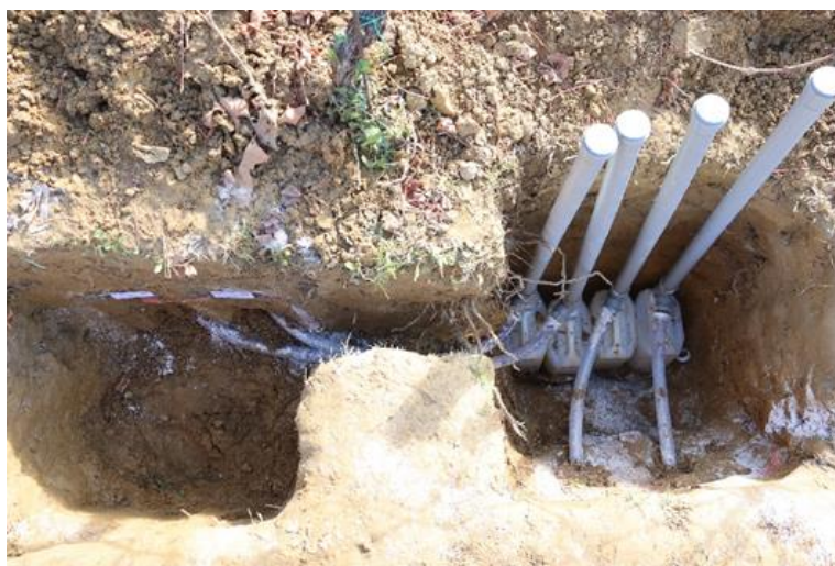
Slika 3.2.1. Postavljene armirane fleksibilne i horizontalne cijevi te spremnik za prikupljanje procjedne vode.
