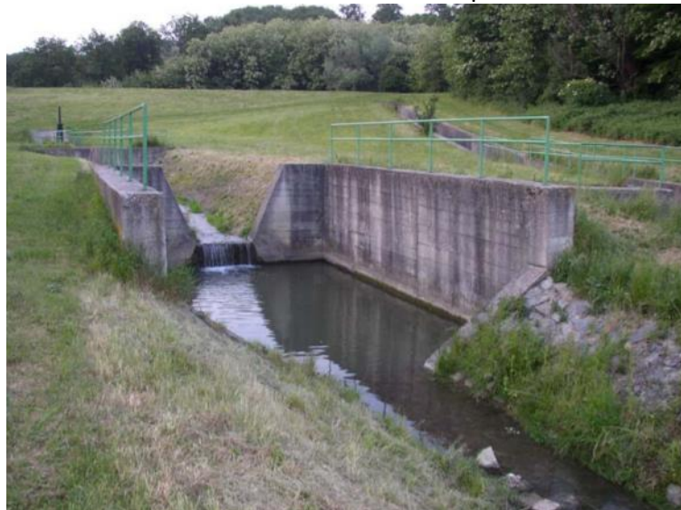
Slika 2.3: Hidrotehnička stepenica
