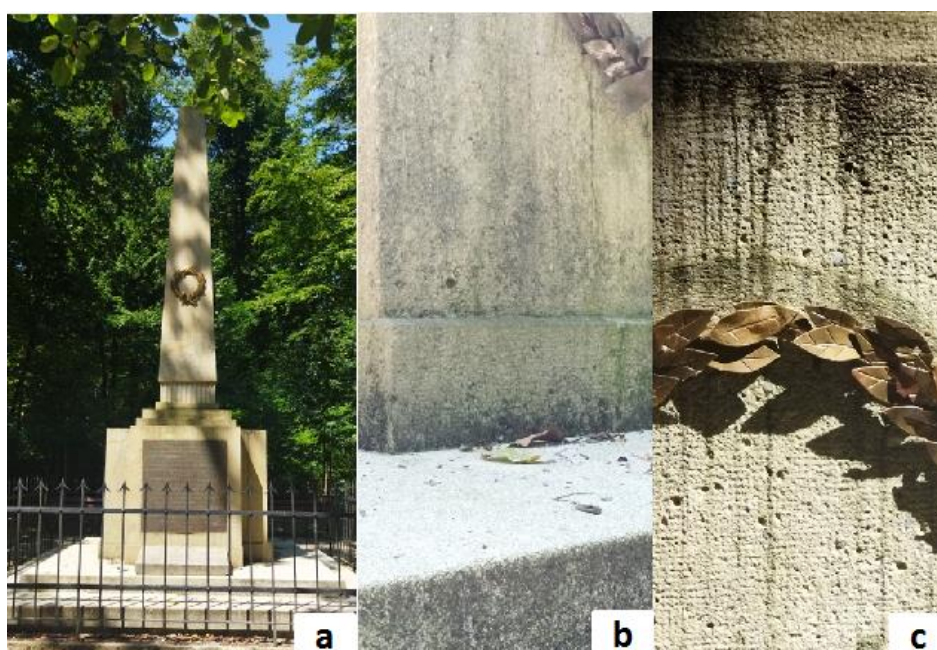
Slika 3.1.10.1. Oštećenja zatečena na Obelisku: a) prikaz Obeliska; b) tragovi prljanja i biološka kolonizacija algama; c) tragovi prljanja i biološka kolonizacija algama.
