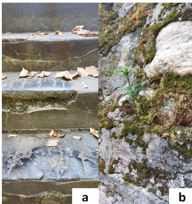
Slika 3.1.8.1. Oštećenja zatečena na Kuli: a) izlizana površina gazišta, odlamanje; b) biološka kolonizacija biljem i mahovinama.
