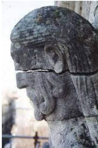
Slika 2.2.1. Horizontalna fraktura izvor: Vergès-Belmin, 2008.
