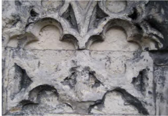
Slika 2.2.3. Odvajanje - mjehuranje Izvor: Oders i sur. 2008.
