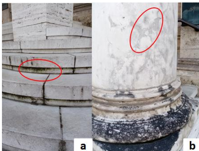
Slika 3.2.6.1. Palača Akademije: a) Prljanje od vlage, isparavanja i alge; b) crna kora (zaokruženo) niže biološka kolonizacija alge i lišajevi.
