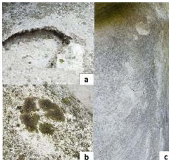
Slika 3.1.11.2. Oštećenja na Egipćanima: a) prsnuće; b) biološka kolonizacija mahovinama i algama; c) površinsko ljuštenje.
