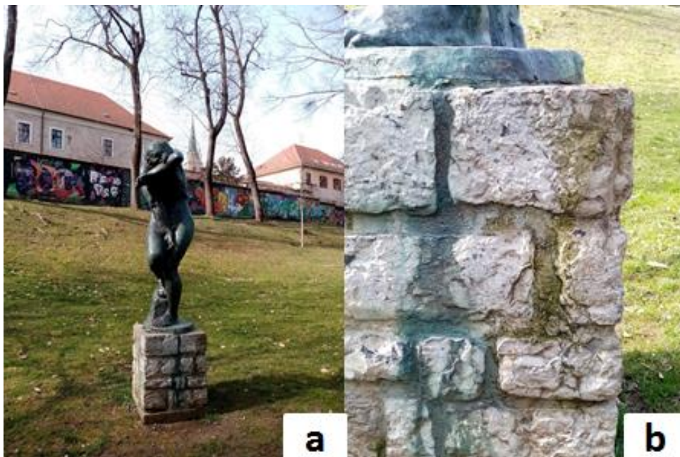
Slika 3.3.6.1.a) Skulptura Stid (Akt); b) oštećenja promjene boje (malahit), biološka kolonizacija algi.
