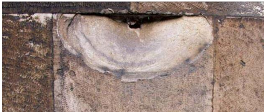
Slika 2.2.4. Odvajanje – prsnucé arhitektonskog kamena izvor: Vergès-Belmin, 2008.
