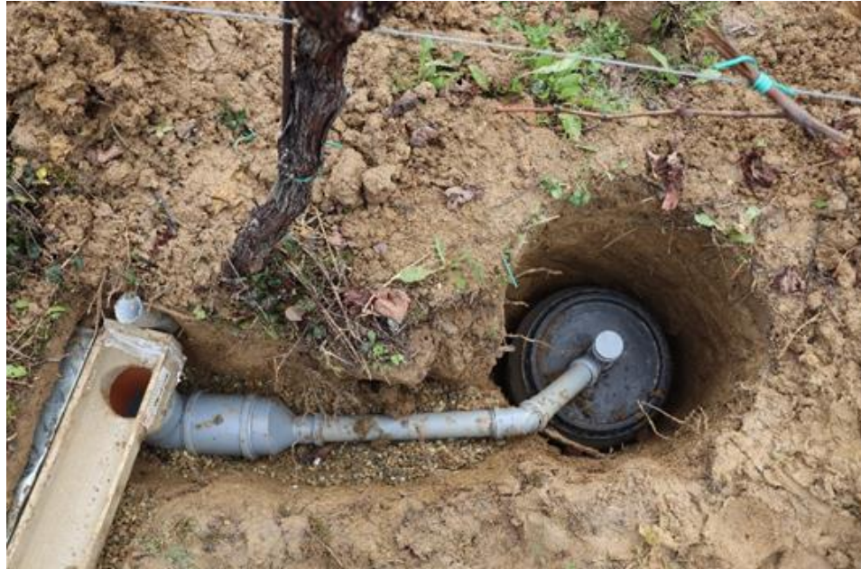
Slika 3.2.3. Instaliranje spremnika i cijevi na određenoj padini zbog osiguravanja otjecanja vode.
