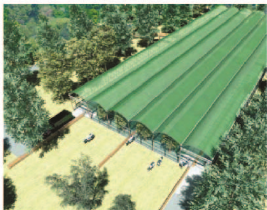
Slika 7.1.2.2 Prikaz strukture staje otvorenog karaktera prema Cow Garden konceptu - greenhouse tip izgradnje
