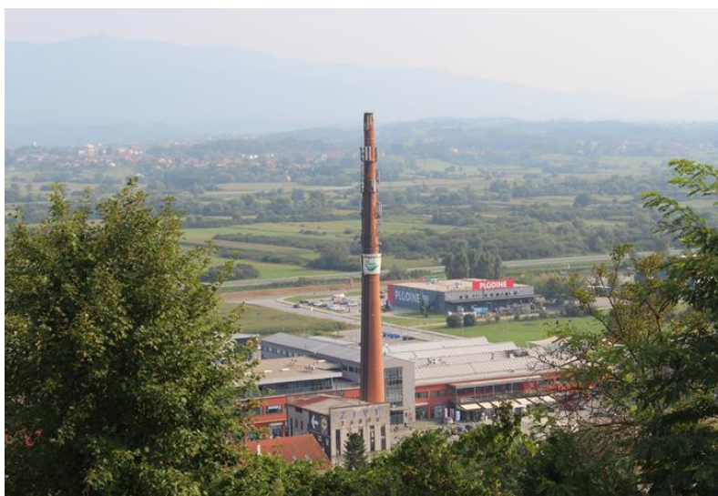
Slika 22_Dimnjak tvornice ZIVT
