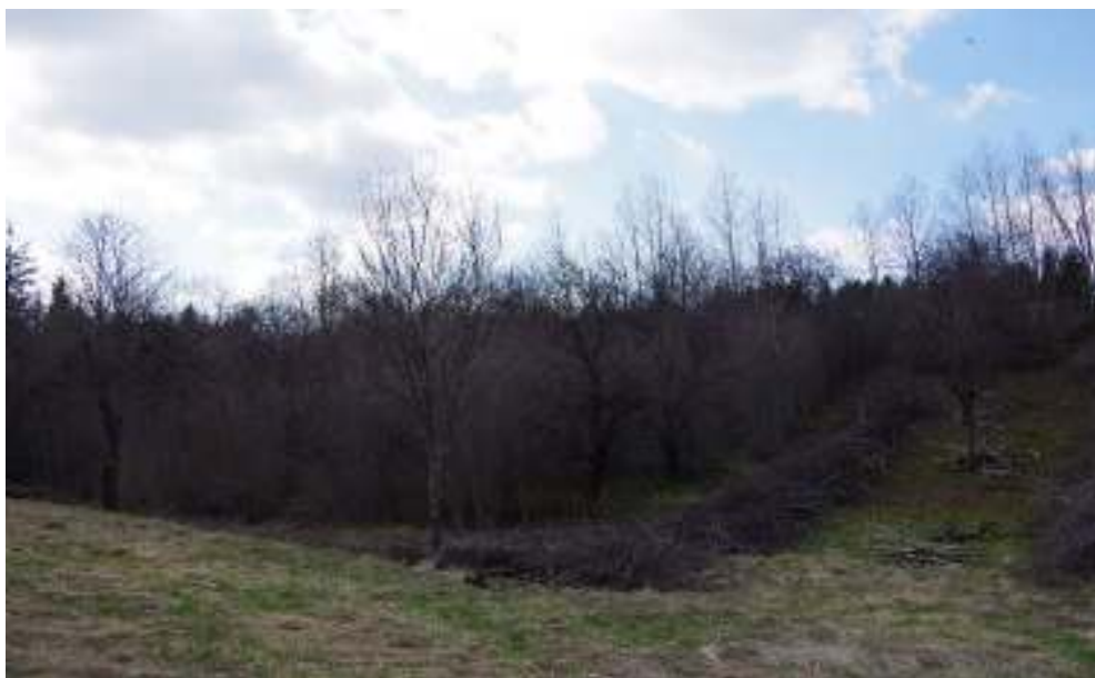
Slika 5 Izgled terena tijekom krčenja (foto: N.W. Brkić)
