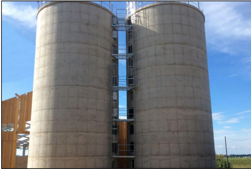
Slika 2.4. Vertikalni silosi (silo-tornjevi)
