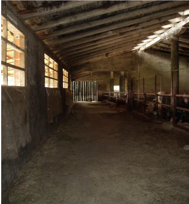
Slika 7. Dio stajskog objekta, hranidbeni hodnik.
