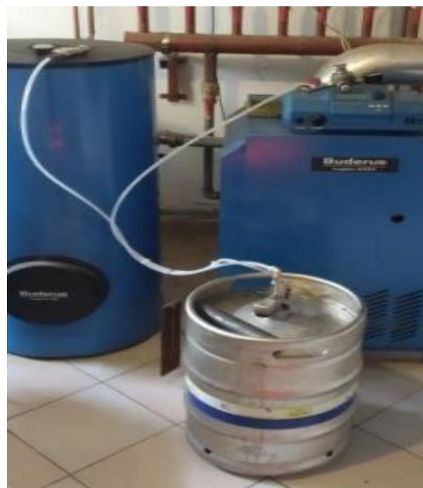
Slika 8. Konstruirani tank za provođenje karbonske maceracije (5. 10. 2019.)
