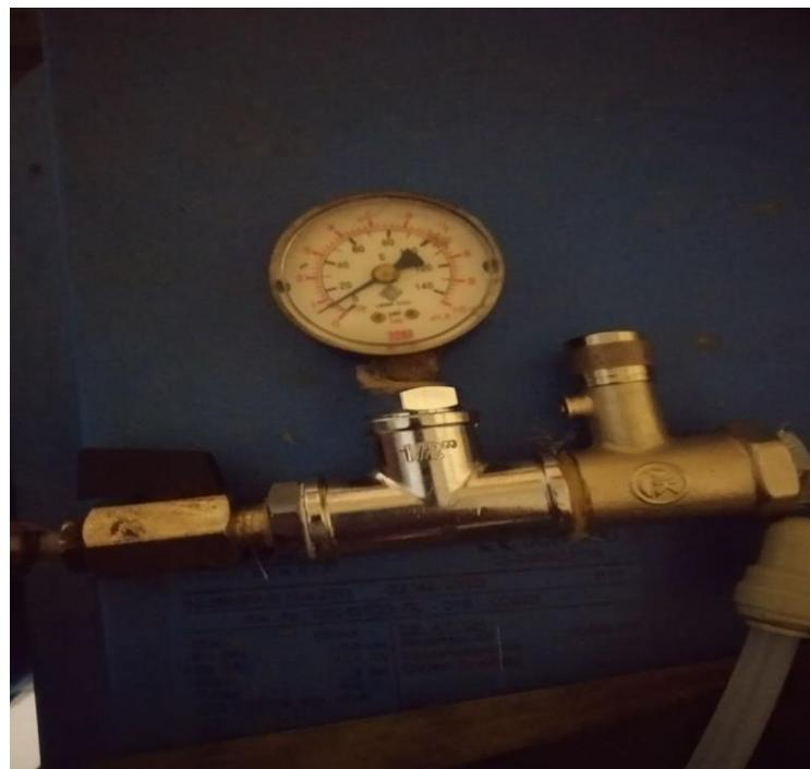
Slika 10. Priključak za ispust tlakova sa sigurnosnim ventilom (5. 10. 2019.)
