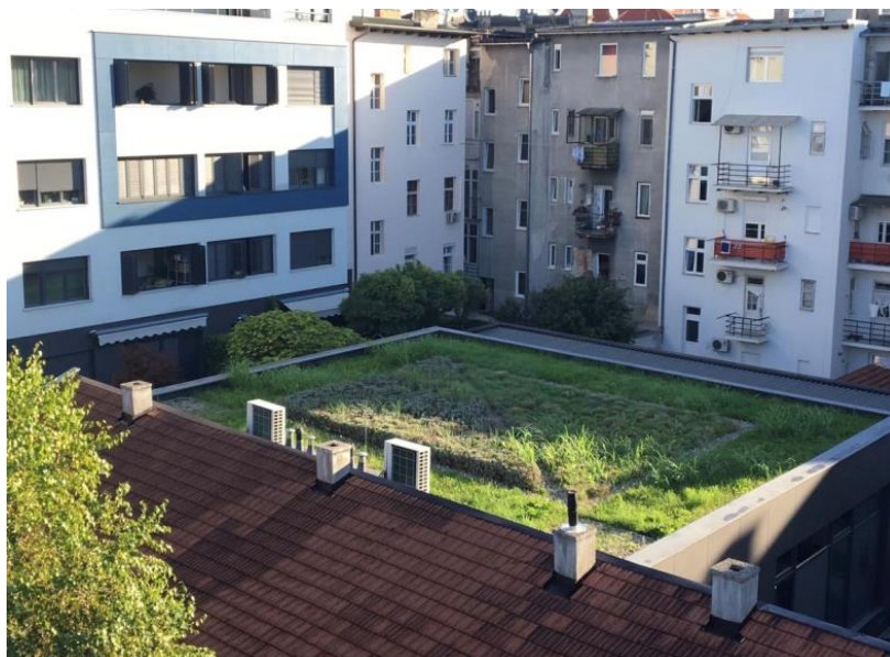
Slika 7. Ekstenzivni zeleni krov, Ul. Ivana Trnskog, Zagreb Izvor: Osobna arhiva, fotografija: Matea Korasić
