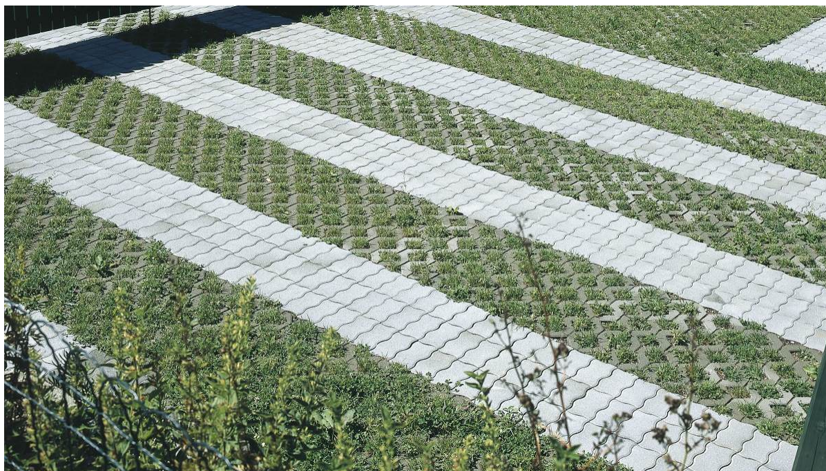
Slika 6. Prikaz betonske travnate rešetke
