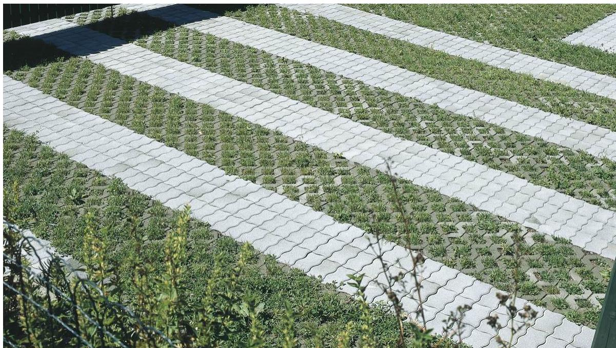
Slika 6. Prikaz betonske travnate rešetke
