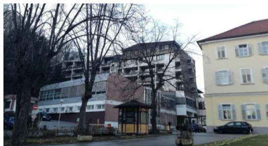
Slika 3.5. Južno pročelje Specijalne bolnice Krapinske Toplice
