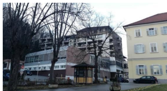
Slika 3.5. Južno pročelje Specijalne bolnice Krapinske Toplice
