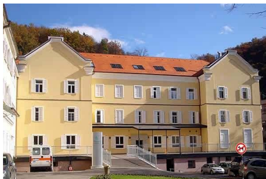
Slika 3.6. Zgrada Specijalne bolnice Akromion
