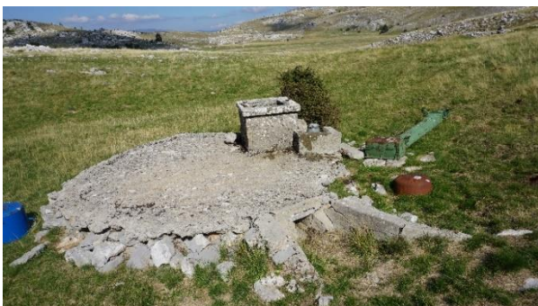
Slika 361. i 362. Gusterna za skupljanje oborinske/slivne vode izgrađena uz brdašće s kojeg se slijeva voda
