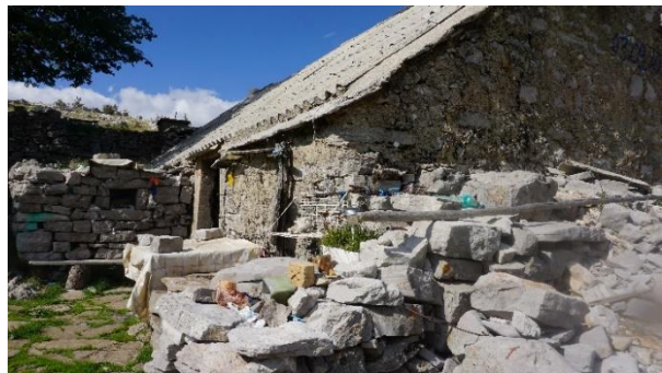
Slika 290. Ostaci košare usječene u brdo s jednim djelomično očuvanim zidom
