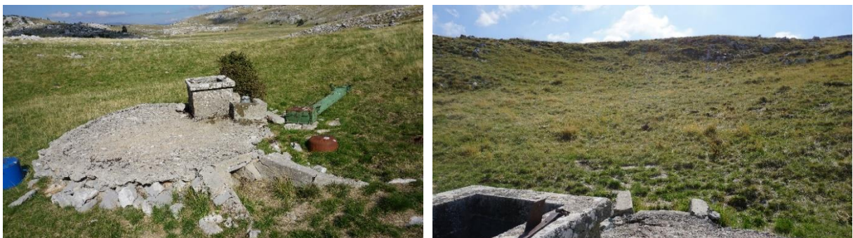
Slika 361. i 362. Gusterna za skupljanje oborinske/slivne vode izgrađena uz brdašce s kojeg se slijeva voda
