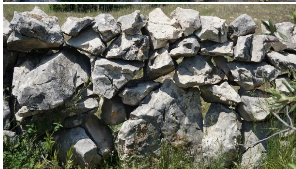
Slika 119., 120., 121., 122. Jednostruki suhozid koji omeđuje pašnjak uz šumu u katastarskoj općini Povljana i jednostruki suhozidi na području Mandre
