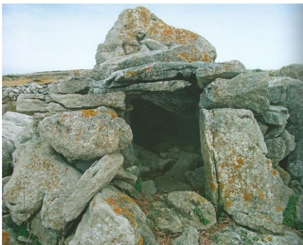
Slika 156. i 157. Nastamba širokih zidova i nastamba na kojoj su zidovi okrenuti prema buri debljine i do 1.5 metra (Izvor: Oštarić, I. (2017.) Stani otoka Paga: Od prapovijesti do danas, str. 388 i 444)
