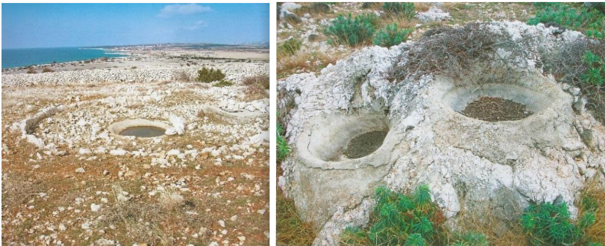
Slika 221. i 222. Betonska kamenica na starom gumnu s rezervoarom za vodu sa strane i kamenica betonirana na prirodnoj stijeni (Izvor: Oštarić, I. (2017.) Stani otoka Paga: Od prapovijesti do danas, str. 266 i 315)
