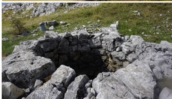
Slika 351., 352., 353., 354. Sklop lokve i suhozidnog bunara na Uniškim Docima
