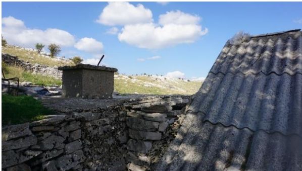
Slika 355. i 356. Bunar građen kamenom i betonom
