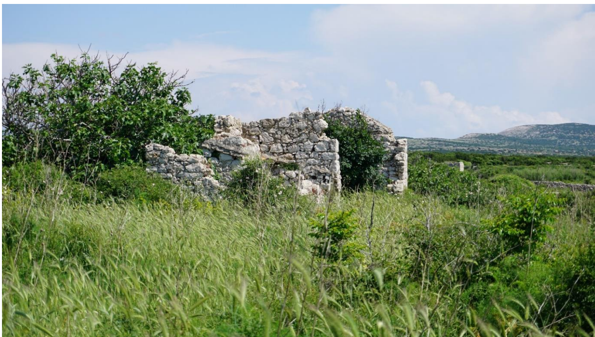
Slika 134. Teško prohodan teren do Popičevog stana (naziv iz knjige Ive Oštarića (2017.)). Objekti su zidani kamenom uz upotrebu vezivnog sredstva, danas u ruševnom stanju bez krova i dijela zidova.
