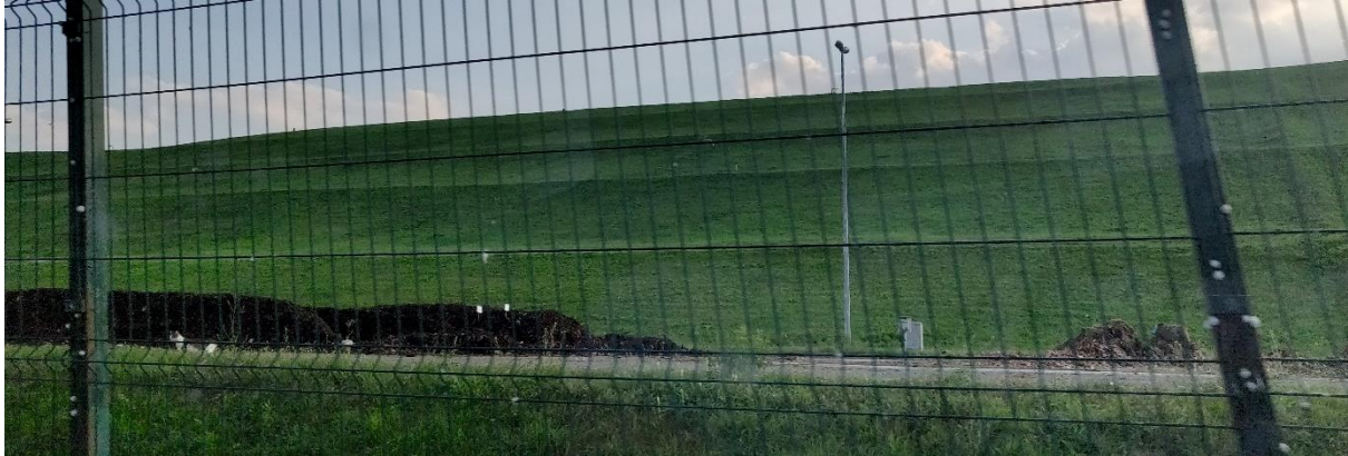
Slika 85: Pogled s točke F na Jakuševec
