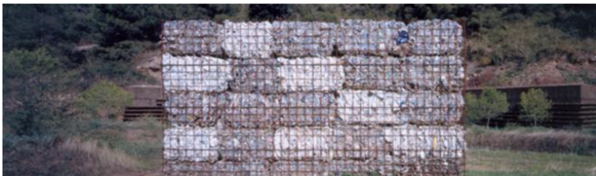
Slika 49: Gabion zidovi s vegetacijom od zemlje i od ostalog otpadnog materijala na ulazu u park iz smjera Gave ( https://www.publicspace.org/works/-/project/c057-vall-d-en-joan-landfill-restoration-1st-and-2nd-phase )
