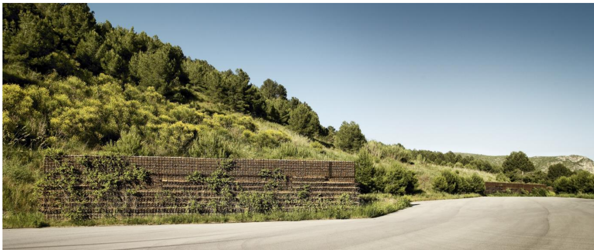
Slika 52: Prikaz trenutne situacije – gabioni
