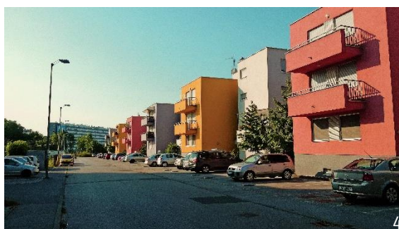
SLIKA 39: Pogled na stambenu izgradnju (2018.)
