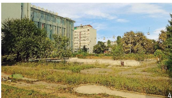
SLIKA 24: Pogled na derutne sportske površine (2018.)
