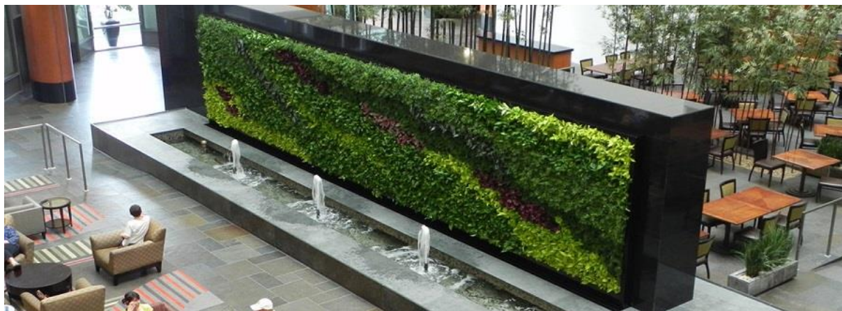
Slika 8 Sustav modularnih panela (»živi zid«) u interijeru (Izvor: www.ambius.com )
