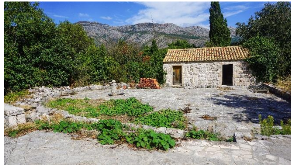
Sl.7.20.6. Gumno s kamenim stupom i pojatom
