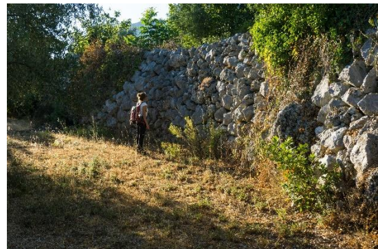
Sl.7.25.4. Visoki podzid terase
