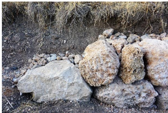
Sl.7.14.4. Početak podzidavanja – kamen vapnanac i breča
