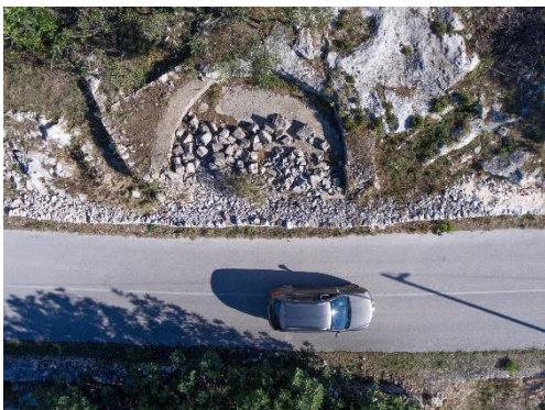
Sl.7.8.7. Srušeno gumno prilikom proširivanja ceste
