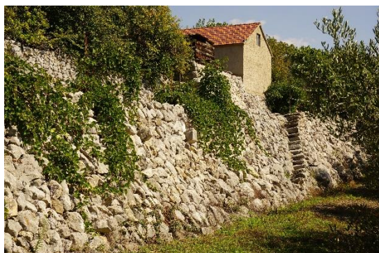
Sl.7.16.3. Visoka „škalpa“ s interpoliranim stepenicama
