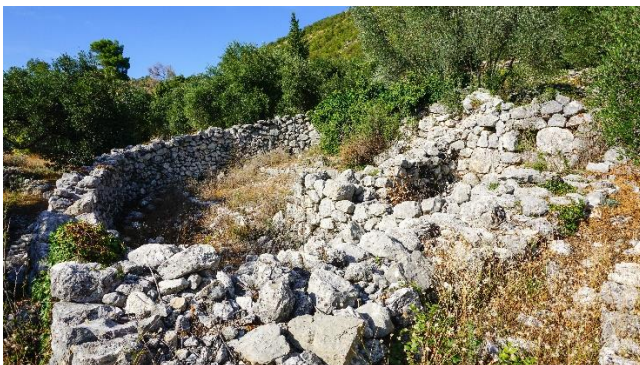
Sl.7.23.7. Kućerica za ovce s oborom i opločanim podom, te manjim kanalima za odvod vode
