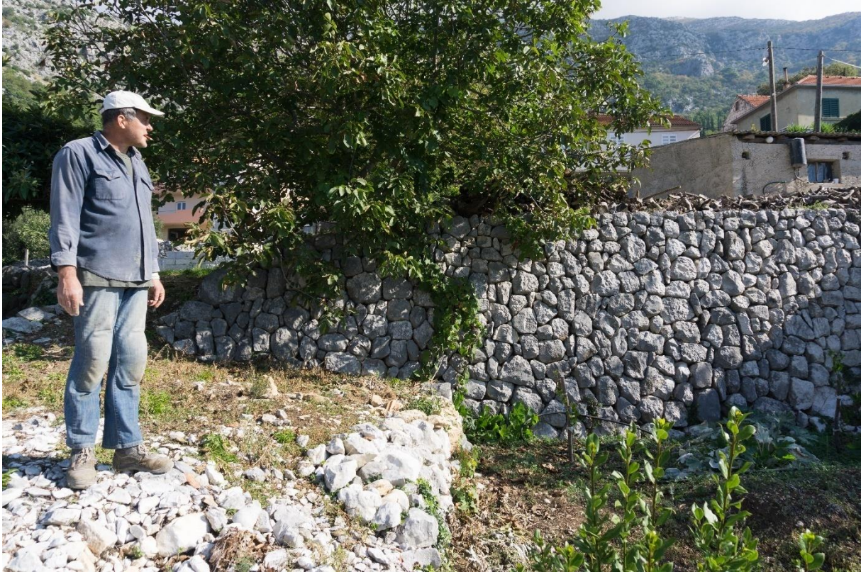
Sl. 8.1.1. Pero Kukuljica kraj podzida kojeg je obnavljao 2005. godine
