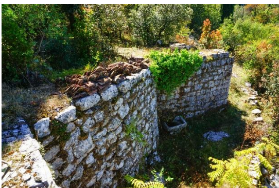
Sl.7.20.7. Potporni zidovi gumna i gustjerne s kamenicom u dnu
