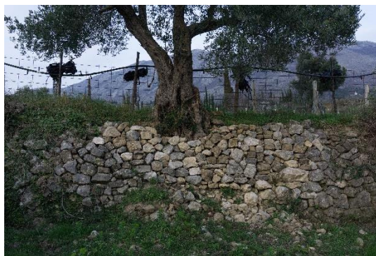
Sl.7.21.4. Obnovljeni podzid u masliniku
