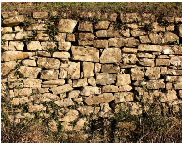
Slika 3.51. Mješavina pravilnih i nepravilnih kamena slaganih u neuredne redove (zapad obuhvata)
