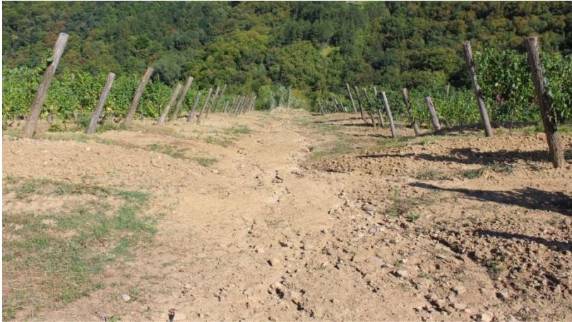
Slika 4.1. Erozivni procesi na pristupnom putu novo zasađenog vinograda
