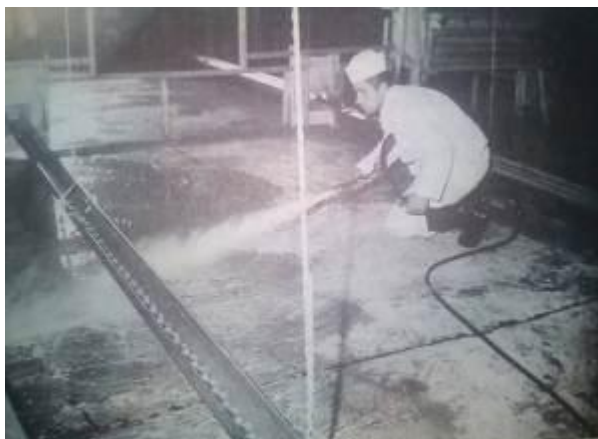
Slika 13. Pranje objekta toplom vodom i deterгентom (Nemanič i Berić, 1995)
