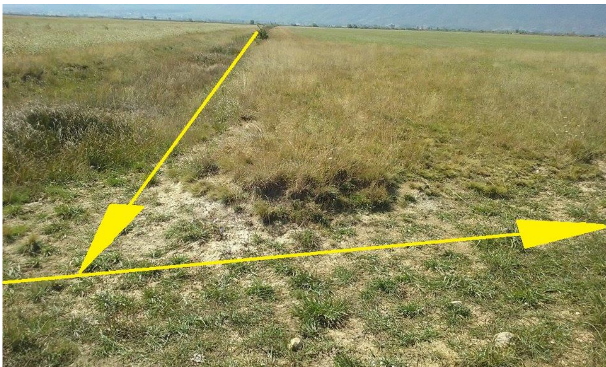
Slika 13.: Ulijevanje kanala III u kanal II reda
