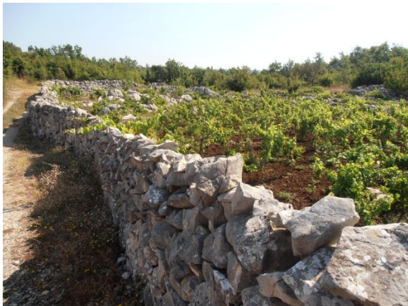
Slika 85.: Jednostruki suhozid, Podgrađe
