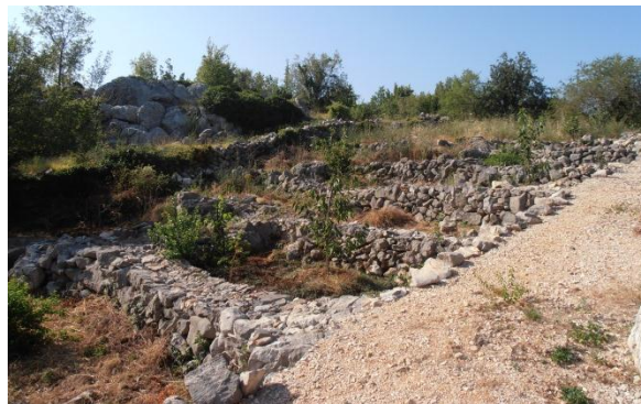
Slika 70.: Potporni suhozidi terasa, Podgrađe
