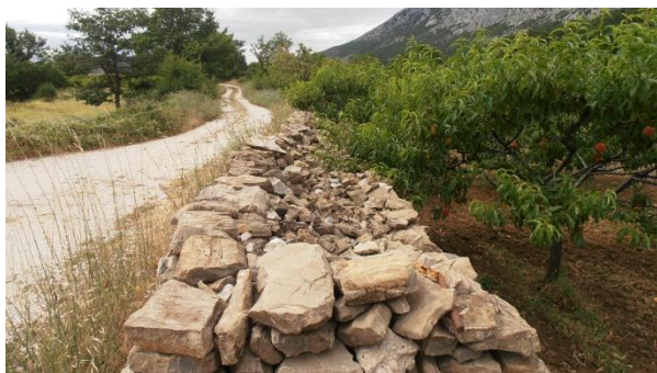
Slika 81.: Gornja obrada suhozida, Čisla
