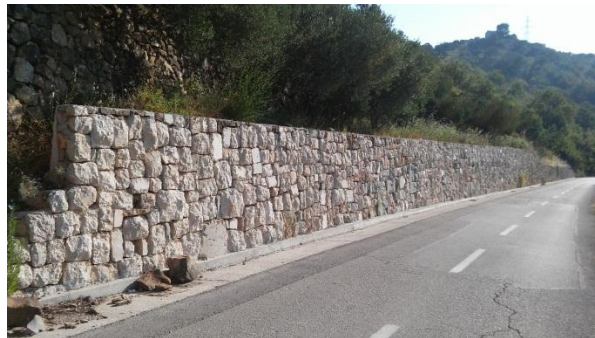
Slika 72.: Potporni suhozid uz prometnicu, Podgrađe
