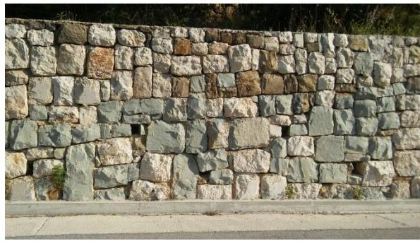
Slika 80.: Način slaganja suhozida, Podgrađe
