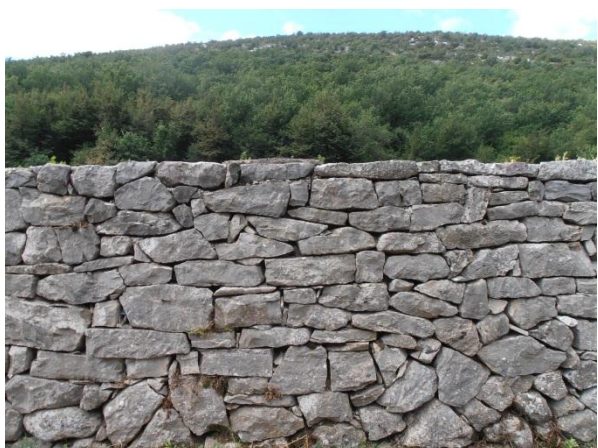
Slika 77.: Način slaganja suhozida, Gata
