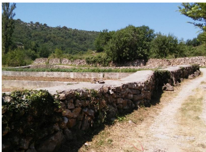
Slika 84.: Gornja obrada suhozida, Smolonje
