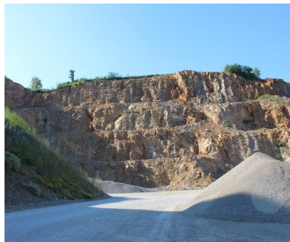
Slika 10. Trenutno stanje radova na eksploatacijskom polju (svibanj, 2024.)
