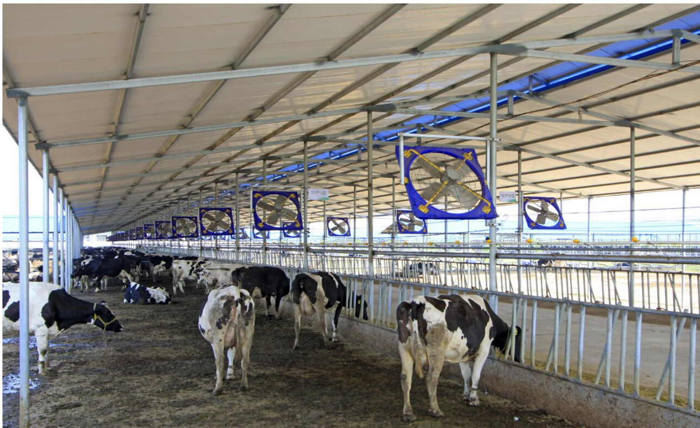
(Slika 5.) – Ventilacijski sustav na modernoj farmi mliječnih krava
