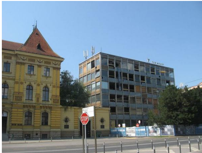
Slika 111. Prikaz nekadašnje zgrade tvornice i tvrtke Ferimport, Izvor: (pogledaj.to)
