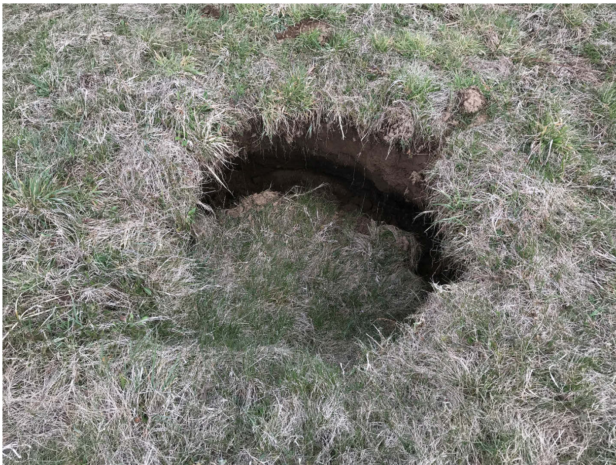
Slika 5. Tipična manja ponikva nastala urušavanjem pokrova otvorena na rubu oranice u blizini rijeke Sunje istočno od naselja Borojevići. Otvor je promjera oko 1 m, a budući da zidovi ponikve imaju prevjesni oblik dimenzije u unutrašnjosti su približno 2,7 x 2,3 m, dok je dubina oko 1 m.
