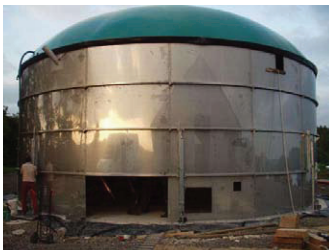
Slika 5. Fermentor u izgradnji
