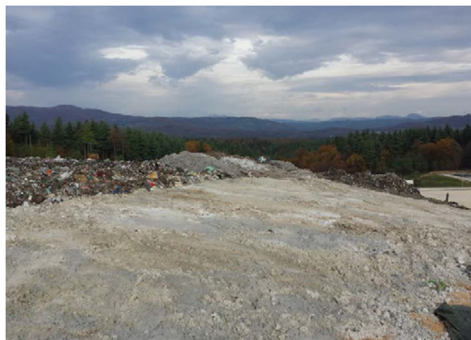
Slika 56. Aplikacija kompozitnog materijala na odlagalištu otpada u Belišću (Livit, 2021)
