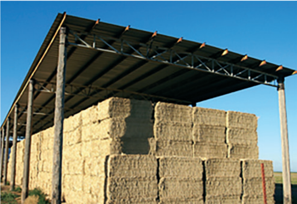
Slika 14. Pokrovna konstrukcija za skladištenje biomase (Izvor: http://bretbergsconstruction.com/services/ )
