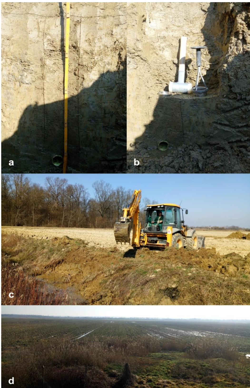
Slika 6. Prikaz pedološkog profila (a), uzimanja uzoraka tla u neporušenom stanju (b), zamuljenost kanala III. i IV. reda i nemogućnost oplavi (c) te prisutnost suvišnih površinskih voda (d) na lokaciji Lupoglav
