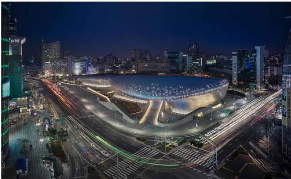
Slika 40 Izgrađeni stadion Izvor: http://www.archdaily.com/489604/dongdaemun-design-plaza-zaha-hadid-architects/ .
