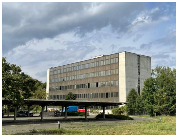
Slika 34.– Upravna zgrada „Diokija“ (S-I)
