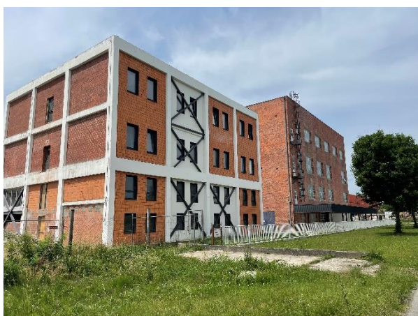
Slika 35.– Degradirana industrijska građevina (S-Z)
