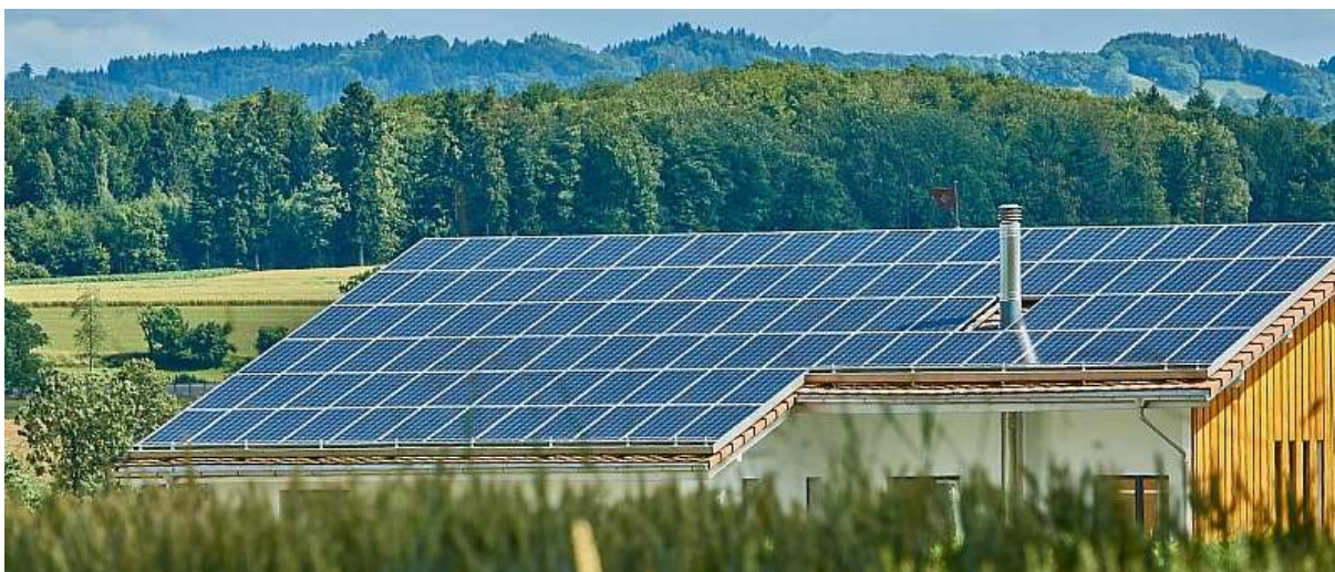
Slika 10. Primjer fotonaponske elektrane na gospodarskoj građevini, izvor: https://www.zagrebacka-zupanija.hr/ , pristup: 1.9.2022.
