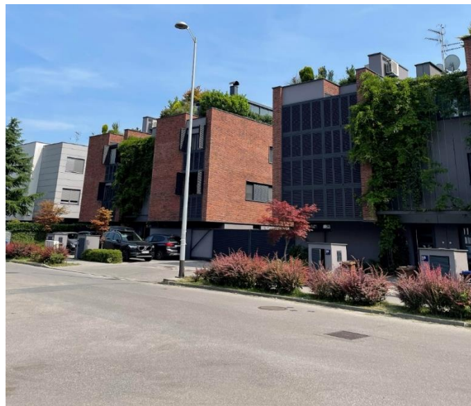
Slika 3.3.4. Vertikalni vrtovi. Hrgovići, Zagreb.
