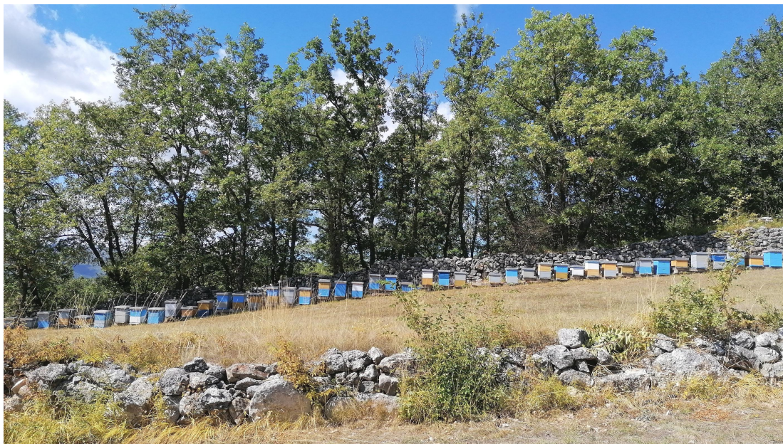
Slika 4.7.3. Djelomično urušena suhozidna gradnja.
