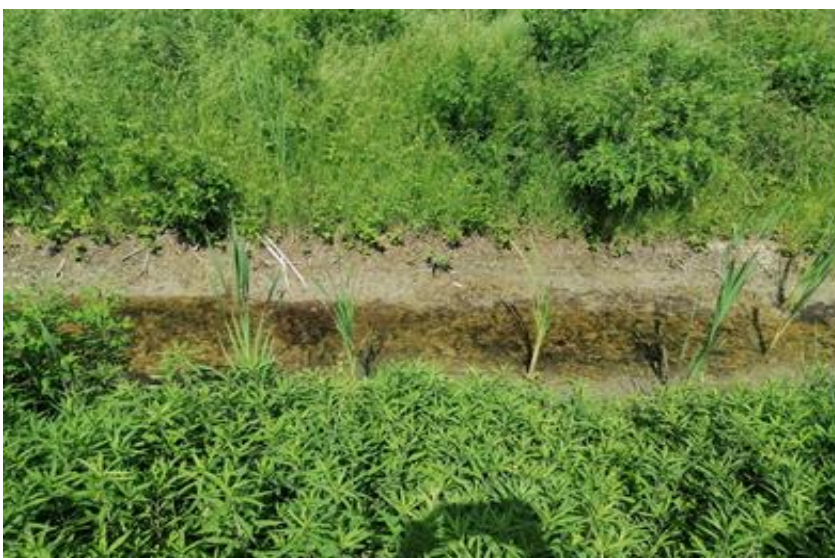
Slika 3.2.6. Melioracijski kanal Preloščica
