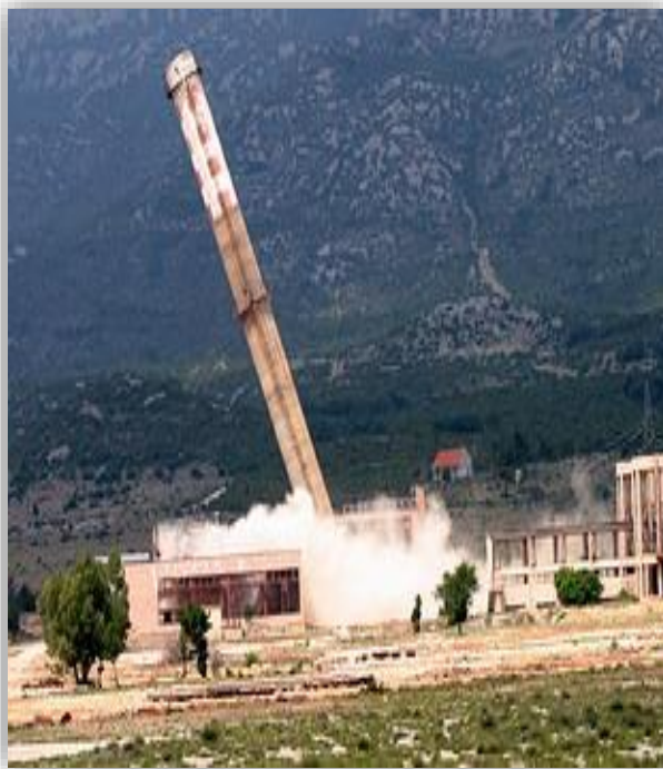
Slika 3. Rušenje dimnjaka posljednjeg simbola tvornice Jadral
