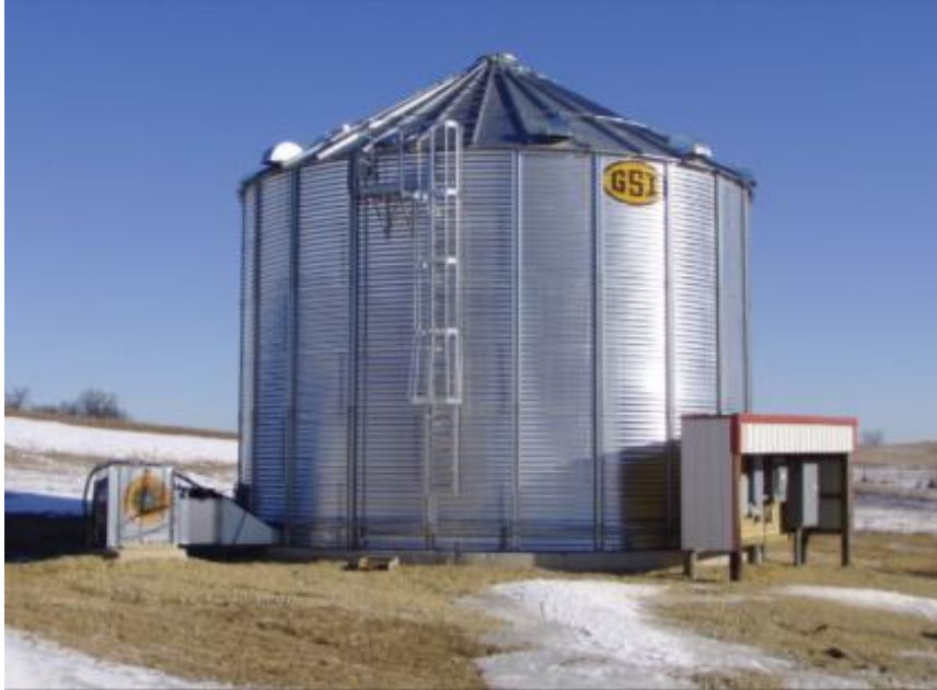
Slika 6. Sušenje u silosu s visokom temperaturom sušenja
