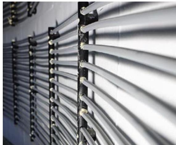
Slika 22. Toplovodne cijevi u digestoru (Martinov M i sur. 2012)
