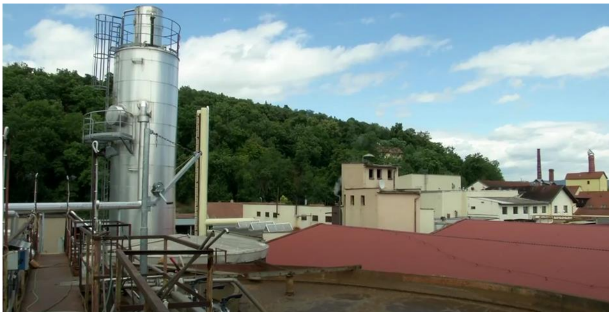
Slika 34. Pivovara Černa Horá, laguna za pročišćavanje otpadne vode i reaktor ( https://www.youtube.com/watch?v=_LS9IKcNwu4&t=1s )
